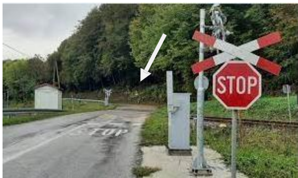
Vendkalim hekurudhor pa mbrojtëse ose gjysmëmbrojtëse
