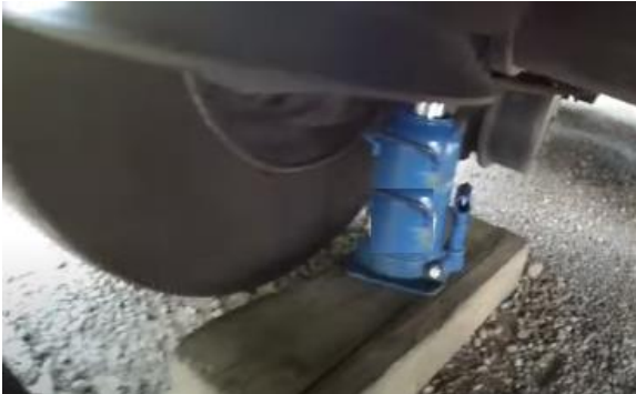
Vinci tahtaya yerleştirilmesi
