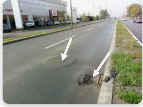
Sirkülasyon yolundaki kanalizasyon şebekesi [3]
