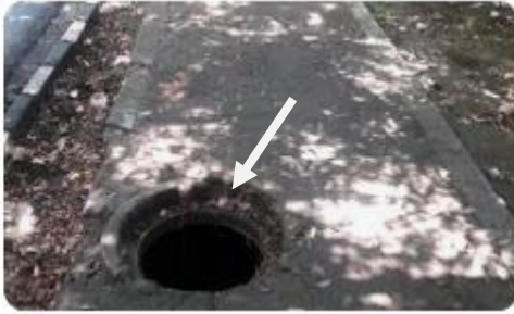
Sirkülasyon yolunda kapaksız kanalizasyon şebekesi [3]
